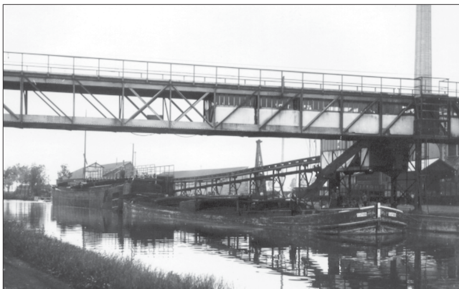
Fig. 10. - Siège Sartis des Charbonnages d'Hensies-Pommerœul. Cheminée des chaudières Bailly-Mathot, vers 1930 (SAICOM, collection Hensies-Pommerœul).
