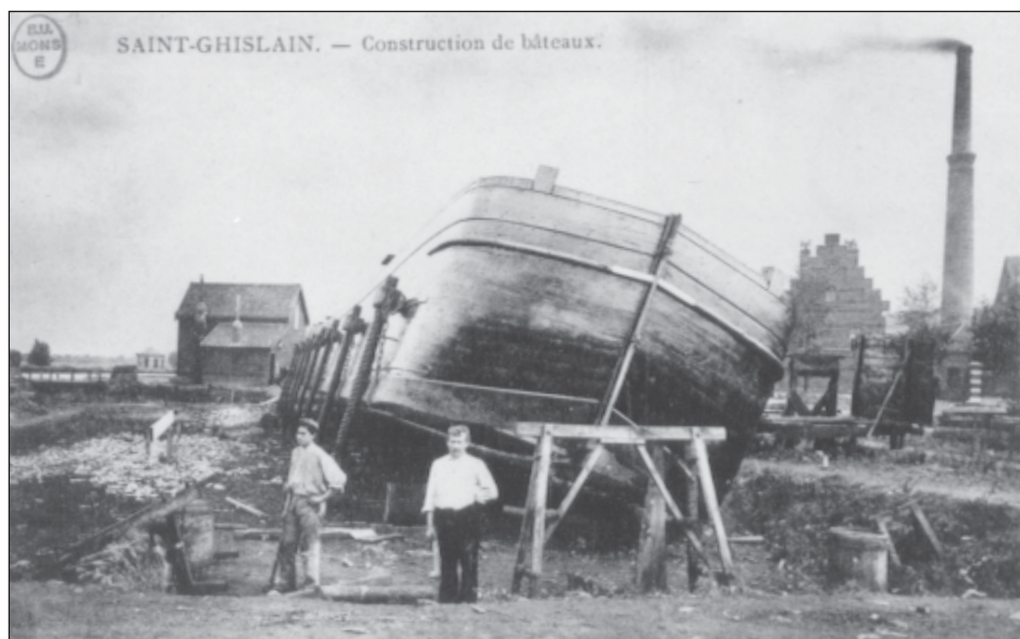
Fig. 8. - Construction de bateaux à Saint-Ghislain, s.d. (Collection SAICOM).
