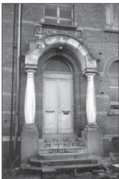
Fig. 5. - Entrée des garçons (©Marie Arnould).
